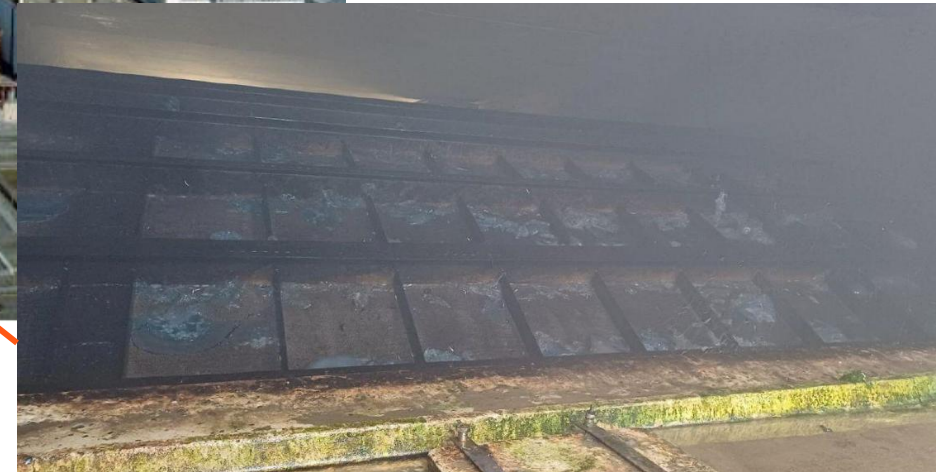
Arrivée des méduses sur les tambours filtrants de la station de pompage de la centrale
