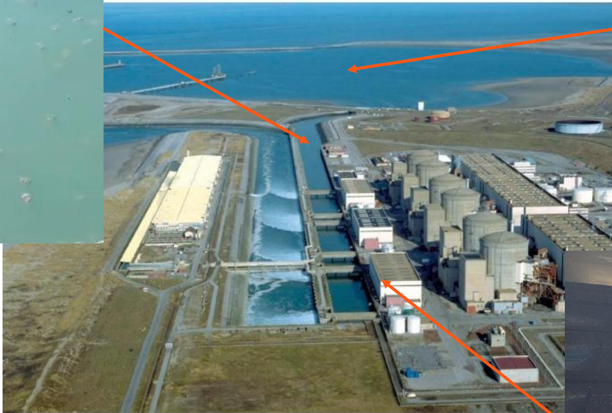
Arrivée des méduses sur les tambours filtrants de la station de pompage de la centrale
