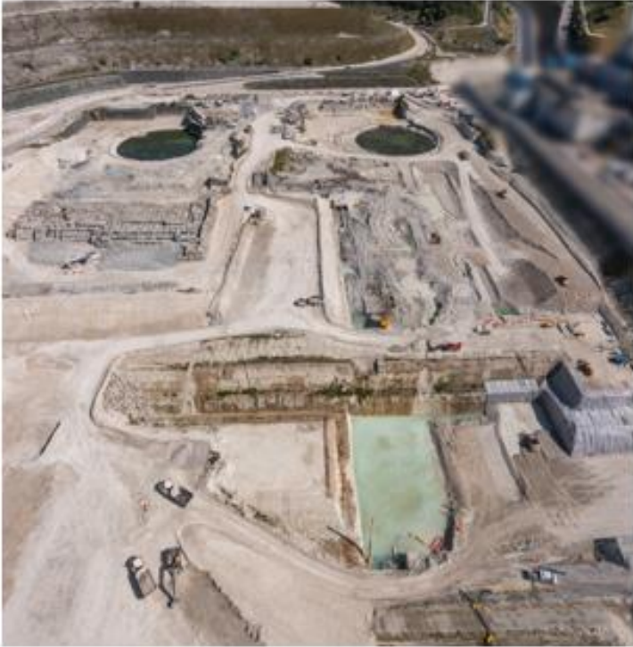
Démolition de plus de 57 000m 3 de béton
