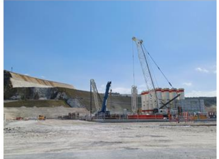
Installation d'une paroi étanche
