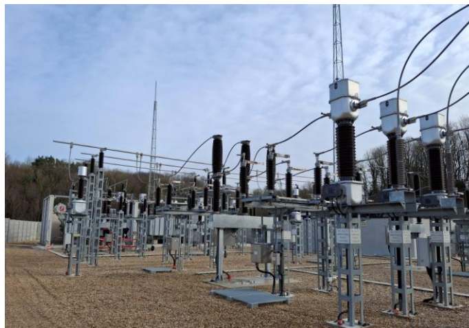
Mise en service du poste électrique
