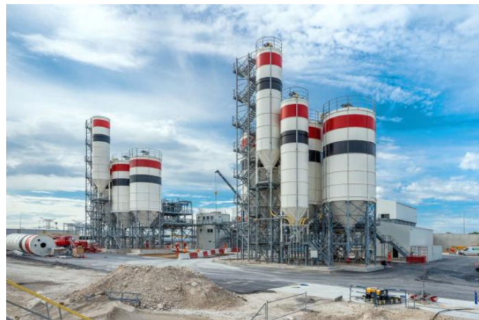
Centrale à béton
