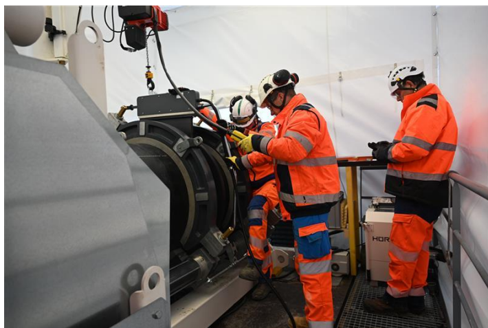
Chantier école soudage tuyauterie
