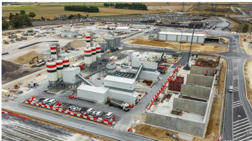
Plateforme 114 – zone logistique
