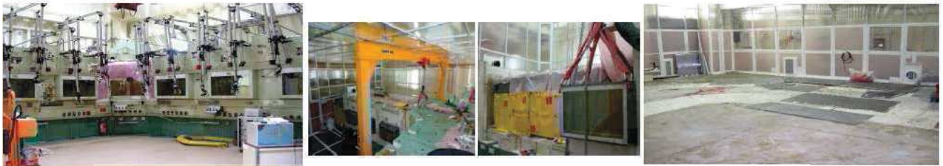
Démantèlement de la chaîne blindée Cyrano – INB 1656 – Fontenay aux roses
