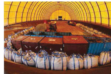
Alvéole de stockage de déchets TFA au Cires (Source : Andra)
