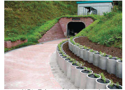
JAEA. Tubes en aluminium de centrifugeuses gazeuses pour parterre de fleurs à Ningyo-Toge
