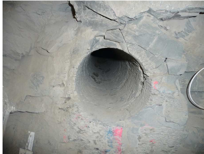
Figure 4-1 du rapport. Breakout d'un forage effectué à partir d'une galerie du laboratoire de Bure (Photographie d'Arjun Makhijani, 18 août, 2010. P1020429)
