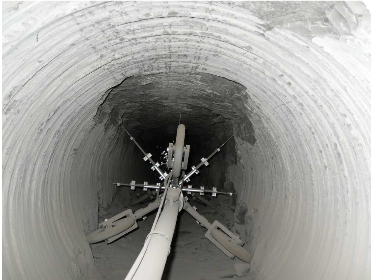
Figure 6-1 du rapport : Hors-profil par rapport à la forme circulaire d'un forage dans le laboratoire souterrain de Bure. Photo prise par Krishan Wahi, 18 août 2010.
