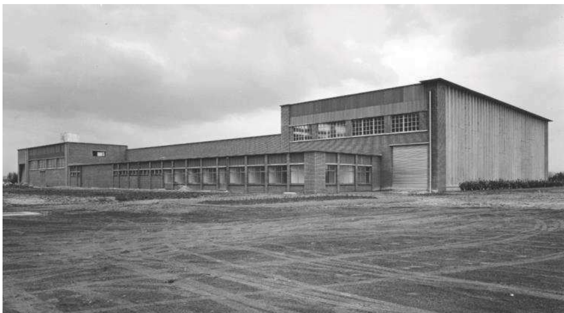
1966-1968 – Construction du Bâtiment 5
