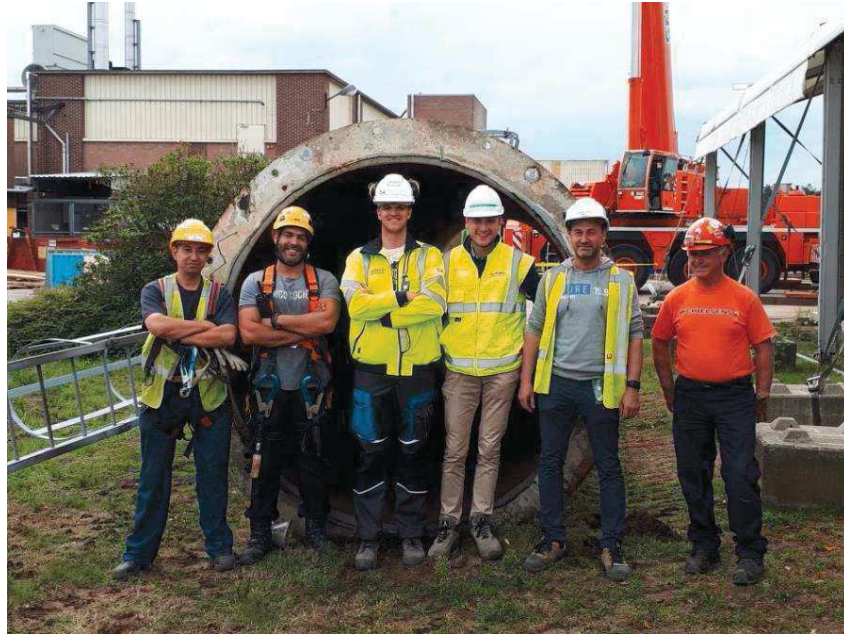
Dépose de la cheminée de ventilation le 28 août 2018
