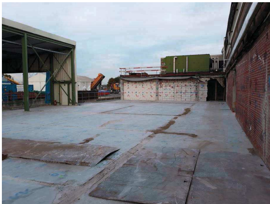
Emplacement de l'ancien magasin poudres (Phase 1) - 8 octobre 2018
