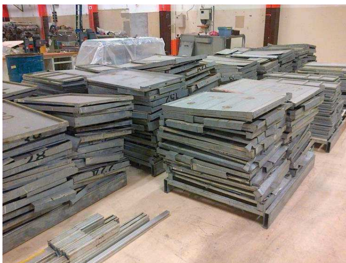
Bât. 5 : démontage des armoires à pastilles
