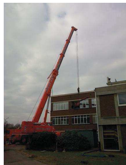
Bât. 2 : Evacuation du pont roulant
