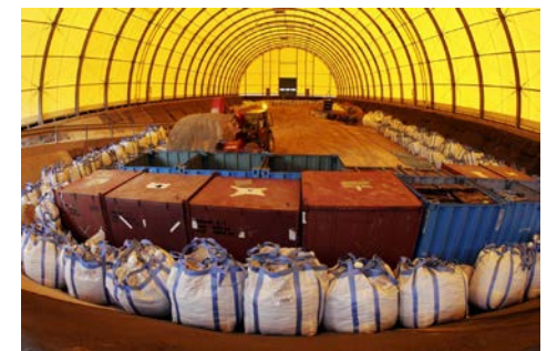
Alvéole de stockage TFA
