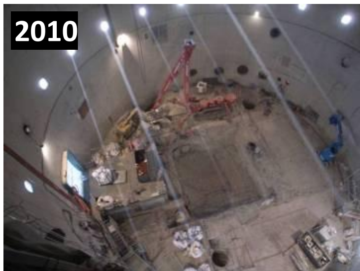
... Démolition des structures internes
