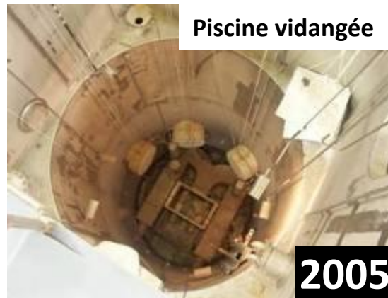
Décuvelage piscine en télé opéré
