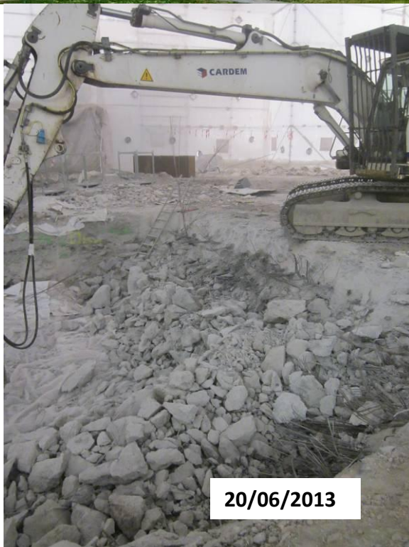
Démolition du radier
