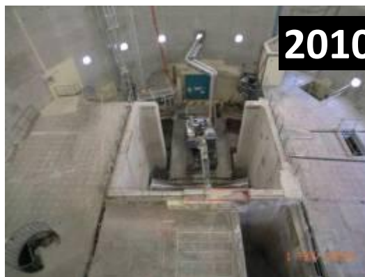
Hall avant démolition
