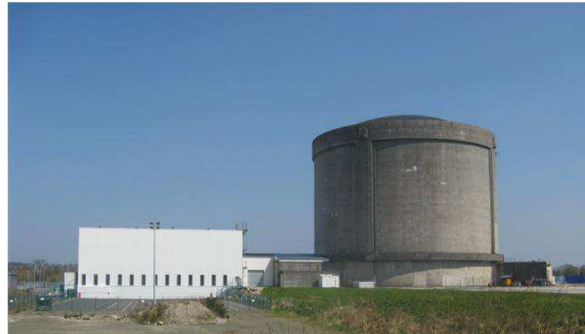
Enceinte réacteur et autres bâtiments
