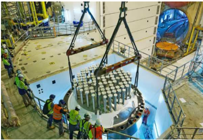
Le couvercle sur son stand d'entreposage prévu dans le Bâtiment Réacteur
