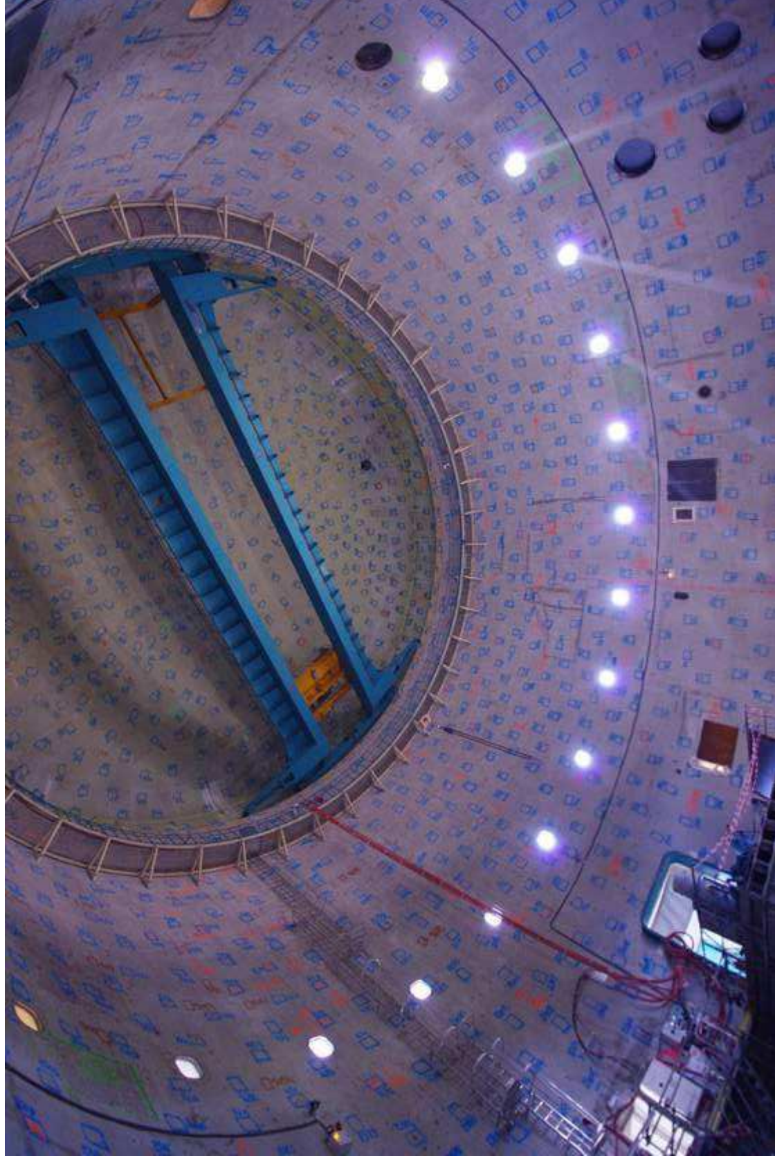
Hall réacteur avec contrôles radiologiques
