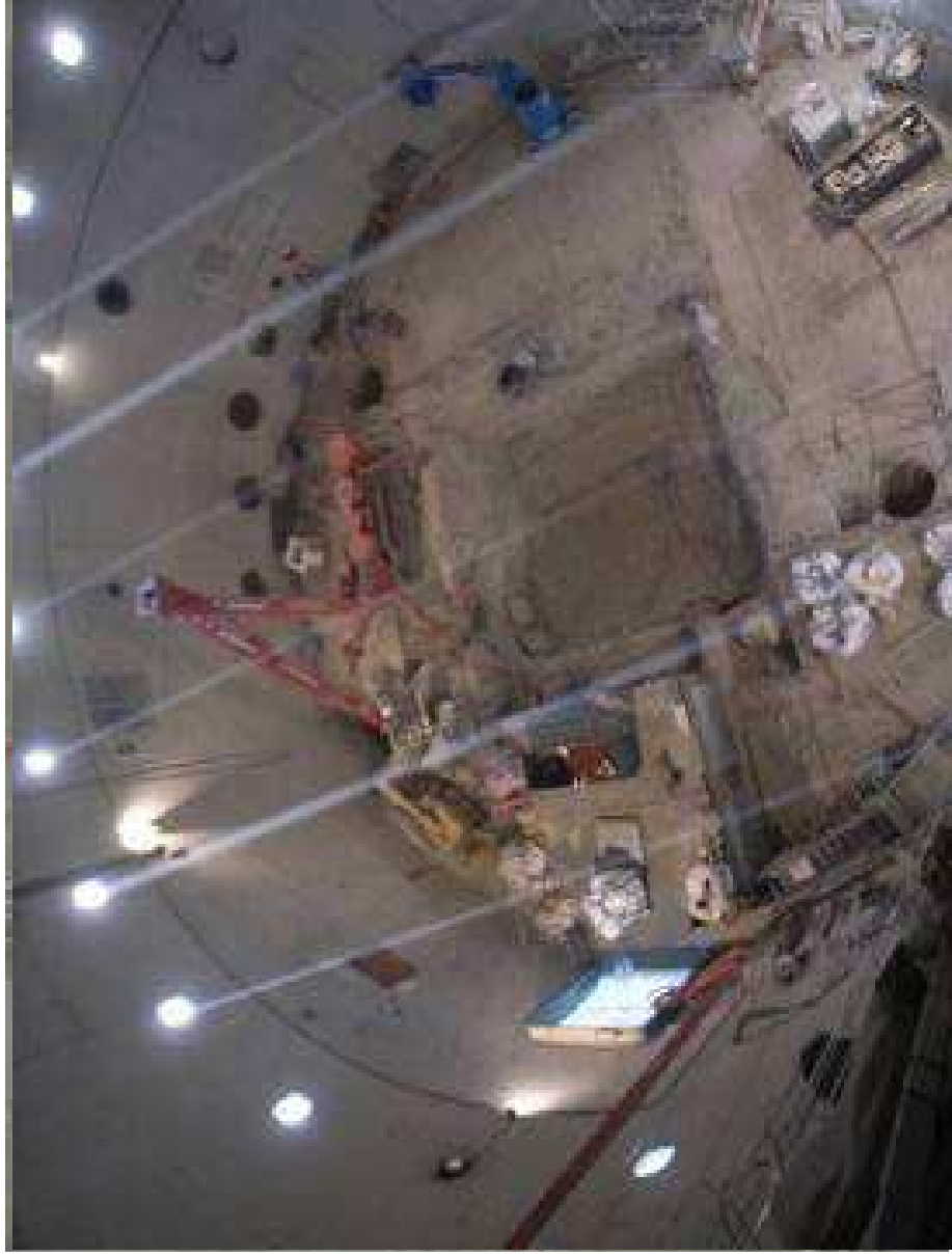
Démolition des structures internes en 2010
