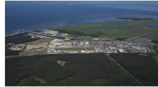
EWN. Vue générale de Greifswald.
