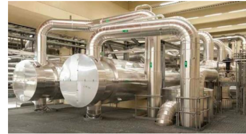
TVO. Les condensateurs d' Oluiluoto.
