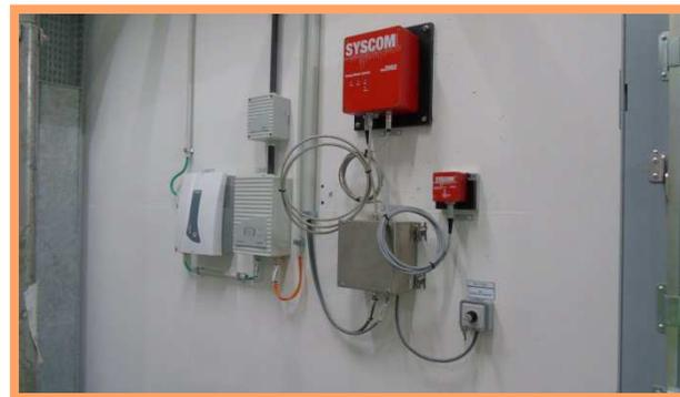
Capteur sismique → DCS
